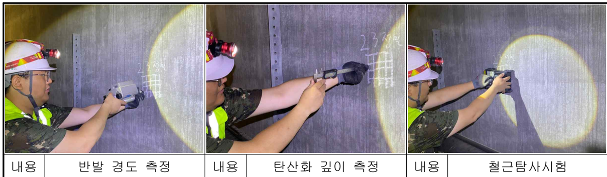
【사진 6.3】 신덕은분기 전력구 재료시험 전경
